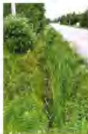
Photographie no 4: La protection des lacs et des cours d'eau naturels commencent loin en amont dans le bassin versant. Les fossés routiers constituent certainement l'un des éléments importants de la problématique, mais il en va de même de nos attitudes et de nos attentes en matière de drainage routier. Il faut à tout prix changer notre conception d'un fossé routier "propre" et s'habituer à y voir une végétation luxuriante. (Photo: RAPPEL, 97-07-07)
