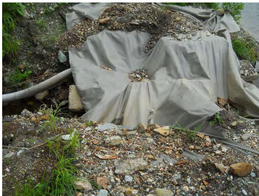
Obstruction au cours d'eau
